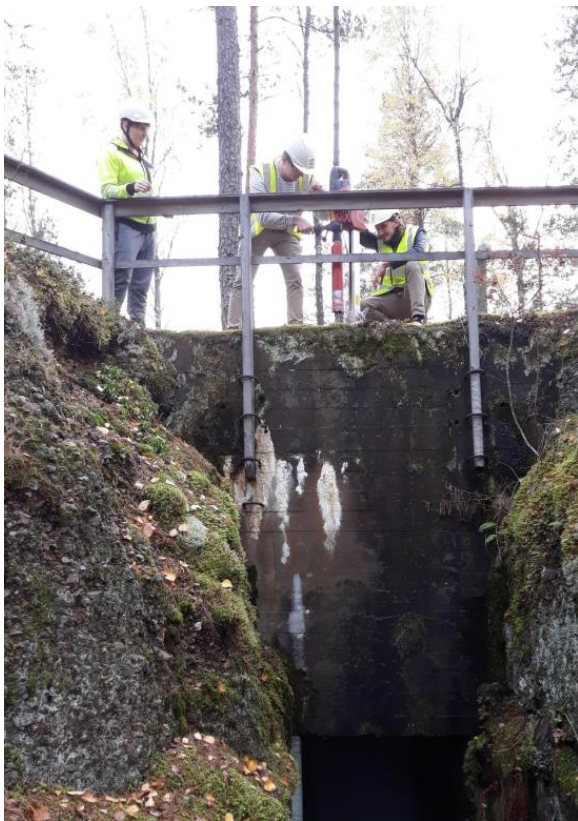
Koekappaleita porattiin korsuista sekä sisä- että ulkopinnoilta
